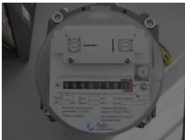
Рисунок 1. Счетный механизм С1Д
